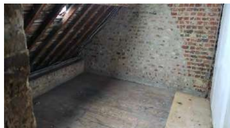
Sous les combles
